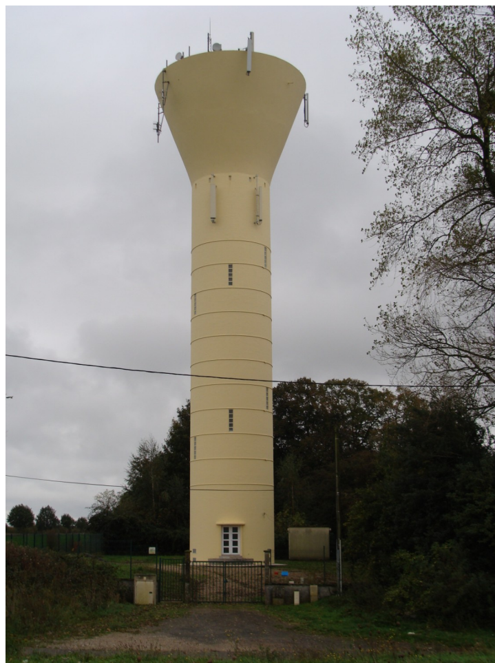
Réservoir de Mouriez (SI Regnaville) Source : DDTM 62
