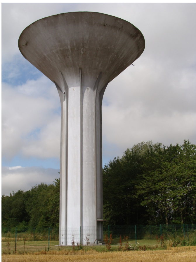
Château d'eau de Warlincourt-lès-Pas (SM Bois-Saint -Pierre)
