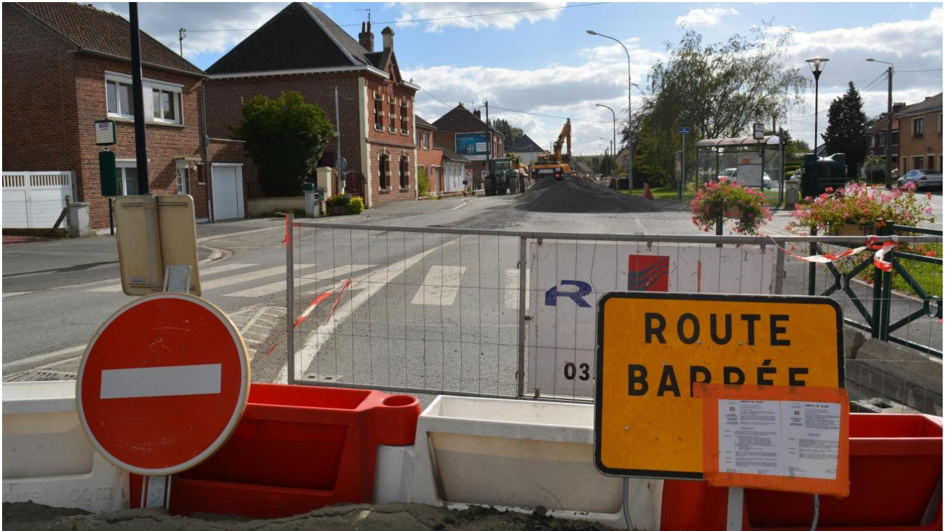
Rénovation de l'ancien réseau d'assainissement rue de Guarbecque à Isbergues (CABBALR)
