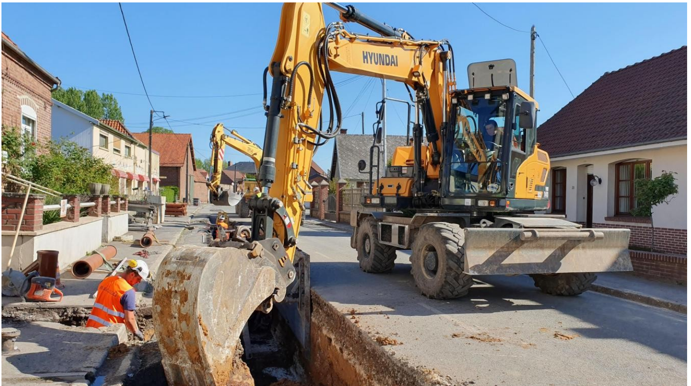
Travaux d'assainissement rue Principale à Tincques (CC Campagnes de l'Artois)
