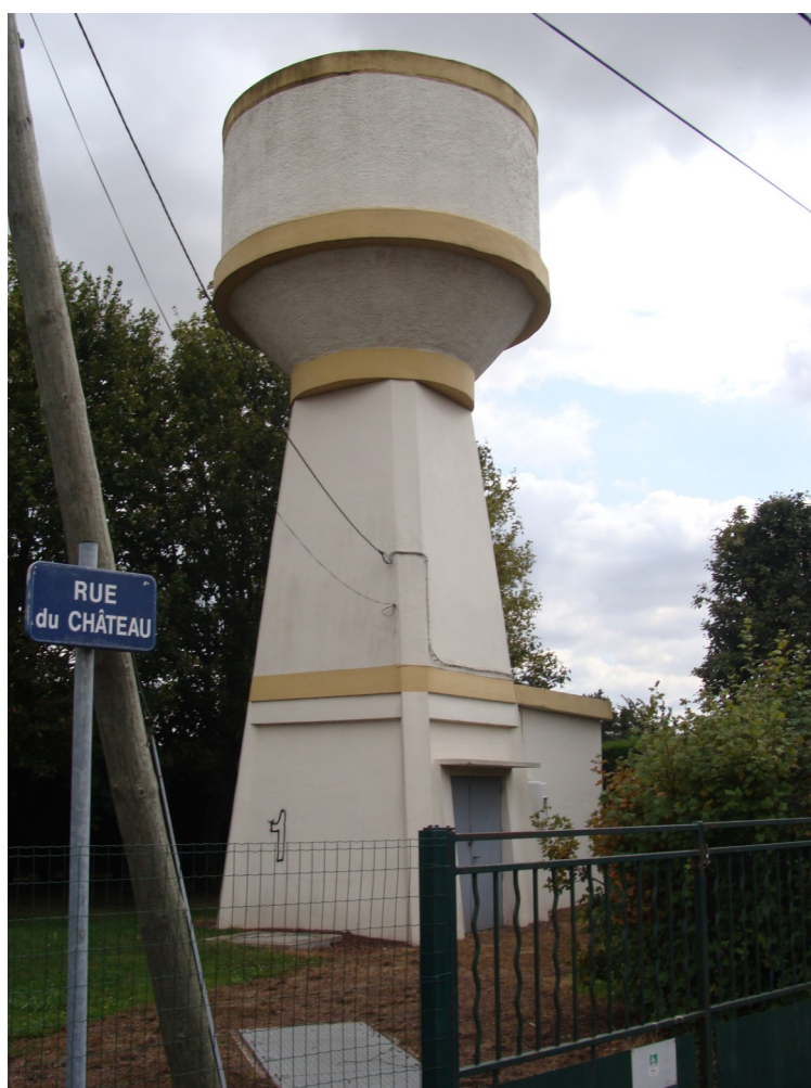
Réservoir de Willerval (CUA) Source : DDTM 62
